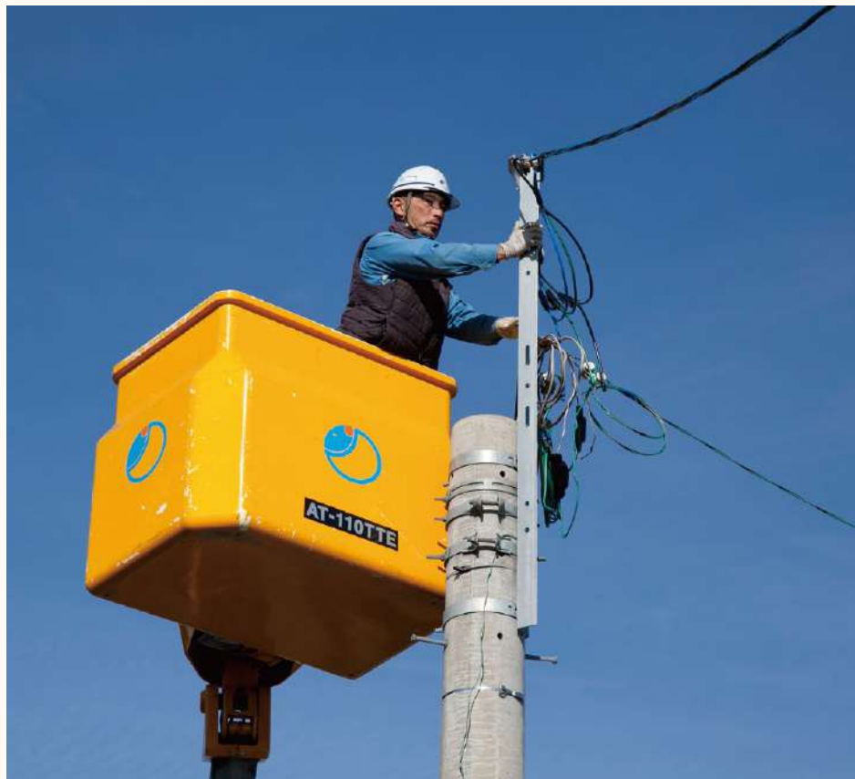
高所作業車で電柱上部に上り、電気の引き込みやメンテナンスなどを行います。
