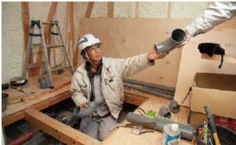
重機を使ったり屋内で配管工事をしたりと仕事はさまざま。
