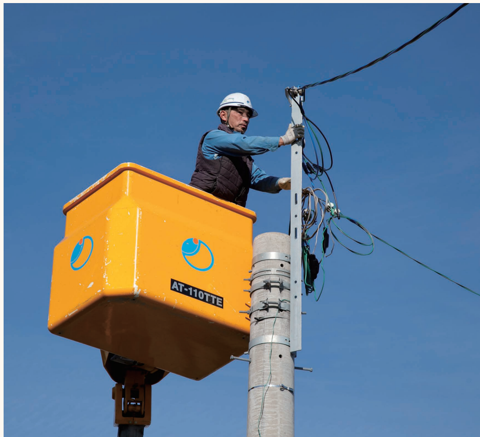
高所作業車で電柱上部に上り、電気の引き込みやメンテナンスなどを行います。
