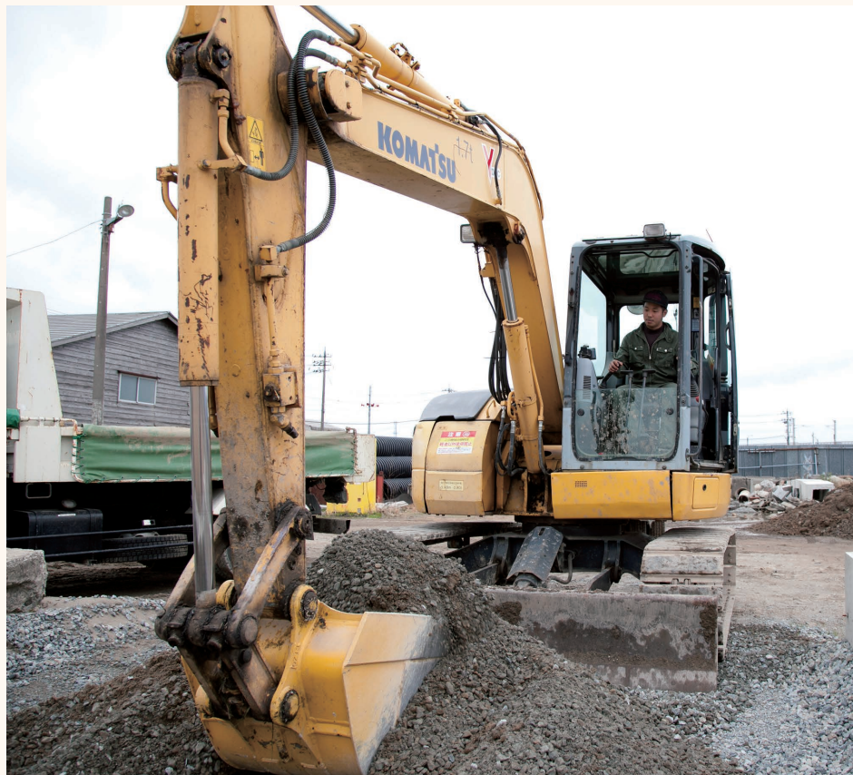
パワーショベルなどの重機は建設現場に欠かせません。これらを運転・操作する免許も積極的に取得します。
