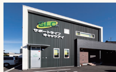
金沢市糸田にある新社屋の風景。1階は身体障がい者を主対象としたグループホームドッグアイ。ショートステイ用の部屋に加え、重度障害者向けの昇降機を備えた浴室もあります。2階には同社のオフィスがあり、ここを拠点に多様なサービスを展開。
