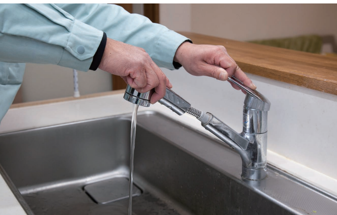
▲キッチンや洗面所水栓の修理や交換にも対応
