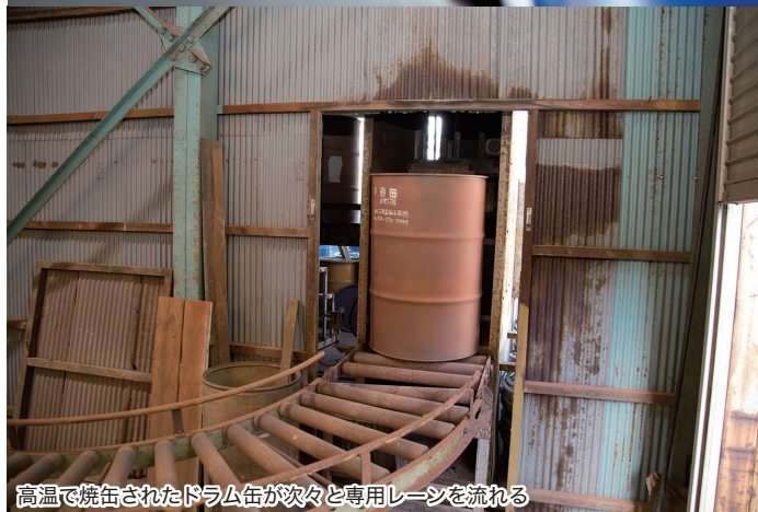
回収したドラム缶は焼缶炉で薬品を落とす
